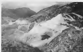
Magnitud di un seccion di construcion di autopista ta muestrá den e panel di tres aki riba. E retrato den centro ta muestra e explosion afamado di 2000 toneladas di dinamite cu practicamente a remonta mitar centro. Na cada banda di e estrato di explosion tin un ences de e vista promer y despues di e tiramento. Trabadoronan a limpia e area di explosion, traha e camina adena y a construi tres galeria ariba e autopista pa proteha contra erosion. Tur di concreto, e galerianan ta como seis metro hanchu.
